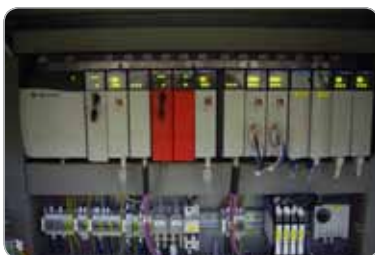
Obr. 2 Riadenie je postavené na PAC ControlLogix a GuardLogix.
