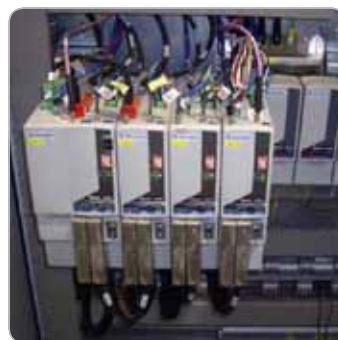
Obr. 4 Riadenie pohybu zabezpečujú servopohony Kinetix 6000.
