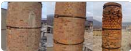
Obr. 5 Kontrola priemyselného komína, zistené poškodenie, nebezpečenstvo pádu tehál
